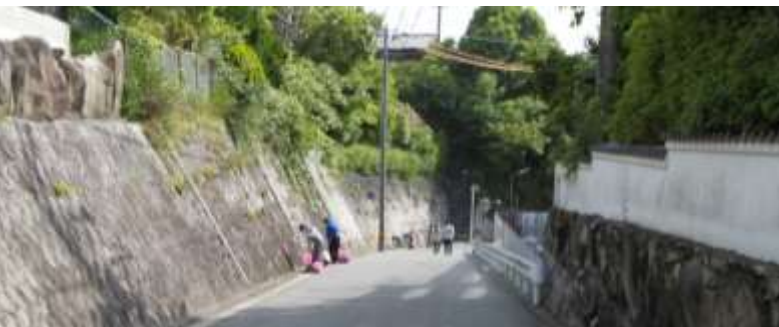
トヨペット研修センター前の道路
